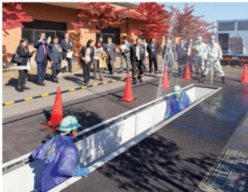
工事現場を再現し、漏水対応を訓練する研修ピット
