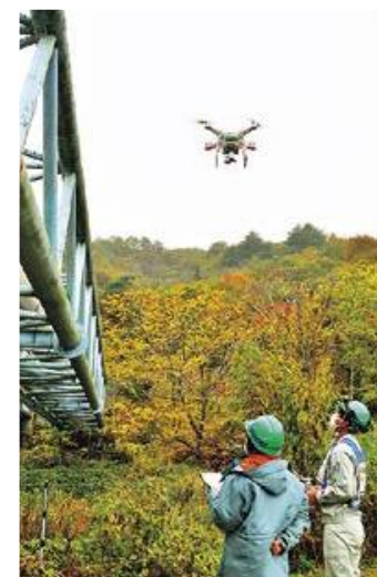
ドローンによる水管橋の点検
