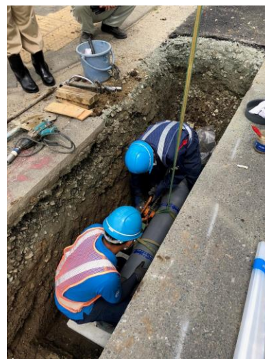
水道管布設工事の様子
