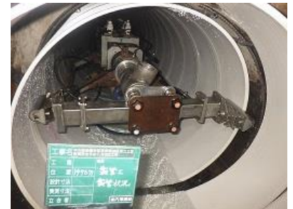
管渠更生工事
