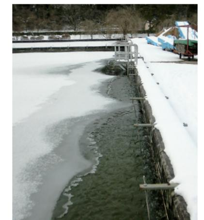
米内浄水場 緩速ろ過池の凍結対策ブロー
