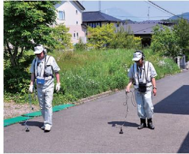
漏水探知器を使用した漏水調査状況
