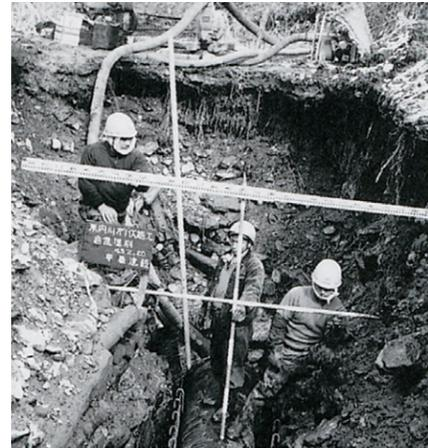
米内浄水場～新庄配水場までのφ600mm送水管布設工事の様子
