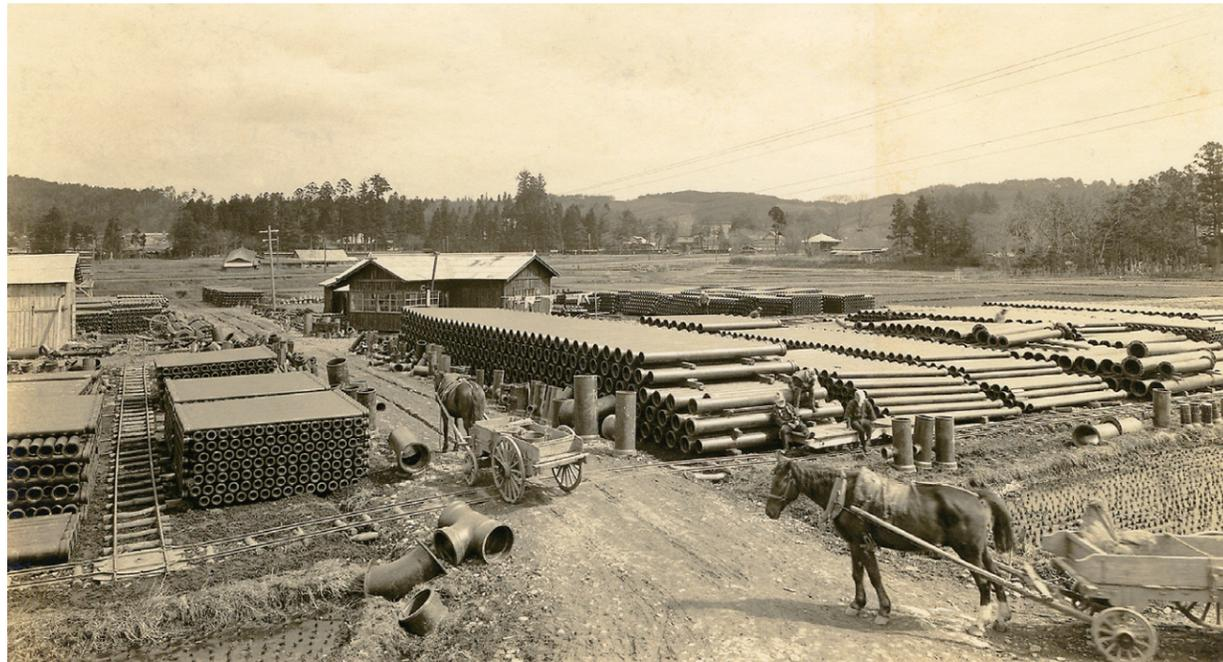
北山地内の鉄管試験所（昭和9年4月6日）。当時布設していた鉄管は約100km。すべての鉄管は市で一括購入し鉄管試験所に一時保管。運搬には荷馬車が活躍していた
