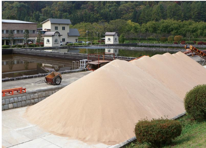
緩速ろ過池から掻き取った使用砂は、洗浄のち、天日で自然乾燥して再利用されている
