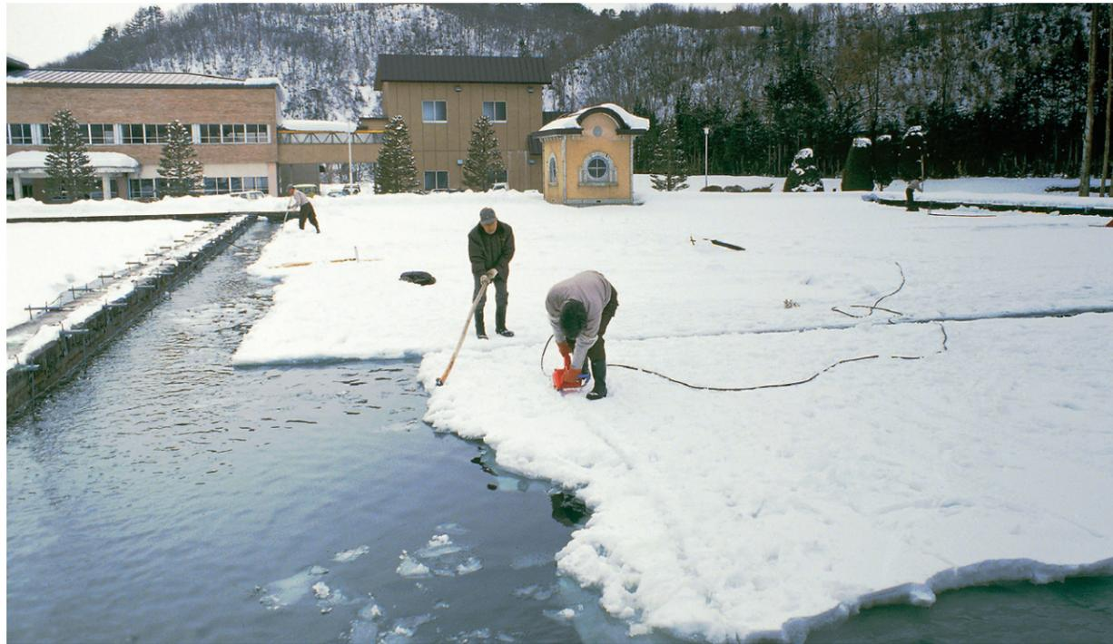
米内浄水場緩速ろ過池での氷の切り出し作業
