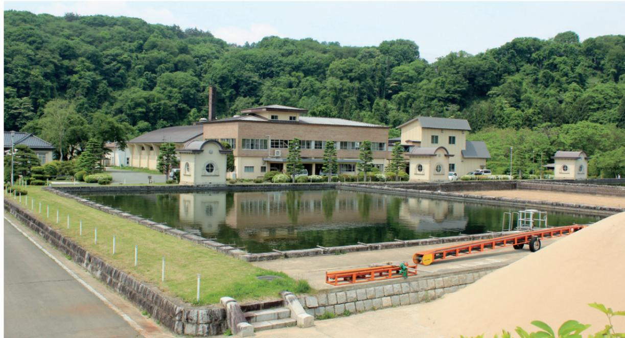
米内浄水場は、浄水方法として急速ろ過のほか東北でも数少ない「緩速ろ過」を有している
