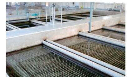
凝集剤を混和した原水をスラリーの下方から通過することにより、懸濁物質は既存フロックと接触し一体となり成長し、上昇水量により沈降速度が大きくなったフロックが、上昇水流から分離して既存の浮遊スラリー層に加わる。攪拌は、回転弁を利用した脈動方式を採用。
