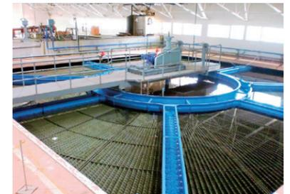
フロック形成を既存フロックの存在下で行い、凝集沈でん効率を向上させる方式。原水が攪拌部に流入し既存スラリーと混和、攪拌後に上昇水量（上澄水）と下降スラリー流（循環）に分離する。
