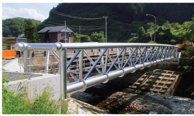
沢田浄水場導水施設改良事業によって築造された水管橋(田の沢)
