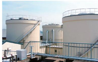
設置当初（第4次拡張）は、地下水と伏流水の電解除鉄急速ろ過槽として使用。現在、原水は雫石川の表流水となっており、沈でん処理後の急速ろ過槽として使用している。
