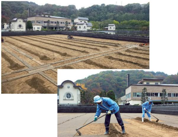
上、ろ過池に掻き取りした汚泥で敷が作られ、その後、泥上げされた汚泥は砂洗いされる
