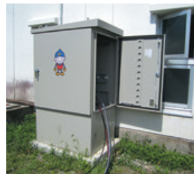
高圧電源車から施設につなぐ接続盤
