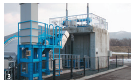
1. 高圧電源車から電力供給 2. 災害に負けない配水管を布設 3. 雨水を河川に放流するゲートポンプ場
