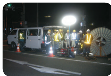
夜間も工事をしています
