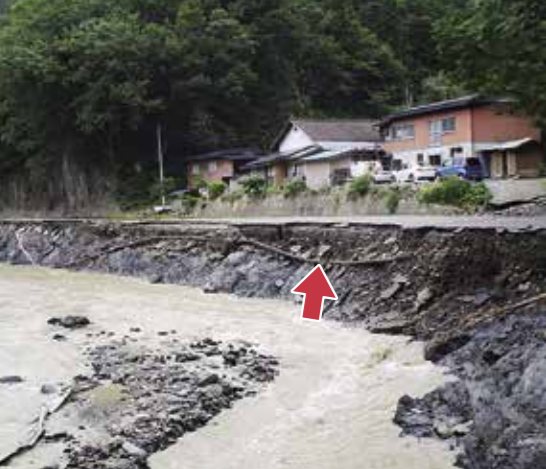
川が氾濫し、崩壊した岩泉町の道路。地中の水道管も損壊し、町内各地で断水となった
