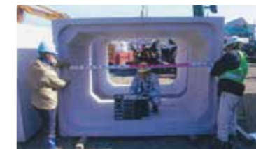
雨水を排水する水路を埋設
