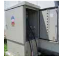
電源車から施設につなぐ接続盤
