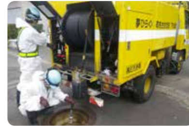
高圧洗浄車によるマンホール洗浄作業
