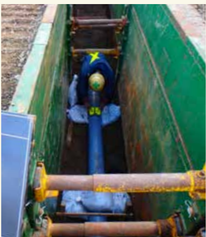
下水道管の工事
