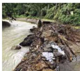
大雨で道路が壊れて水道管がむき出しになったり、取水口に大量の土砂や落葉が入ってきて川から浄水場に水を取り入れることができなくなっただ。
