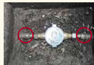
鉛製給水管は、赤く囲っている部分がくすんだ灰色をしています。
