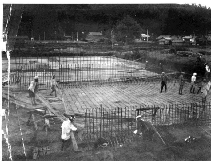
1号ろ過池配筋の様子 昭和8(1933)年9月25日撮影
