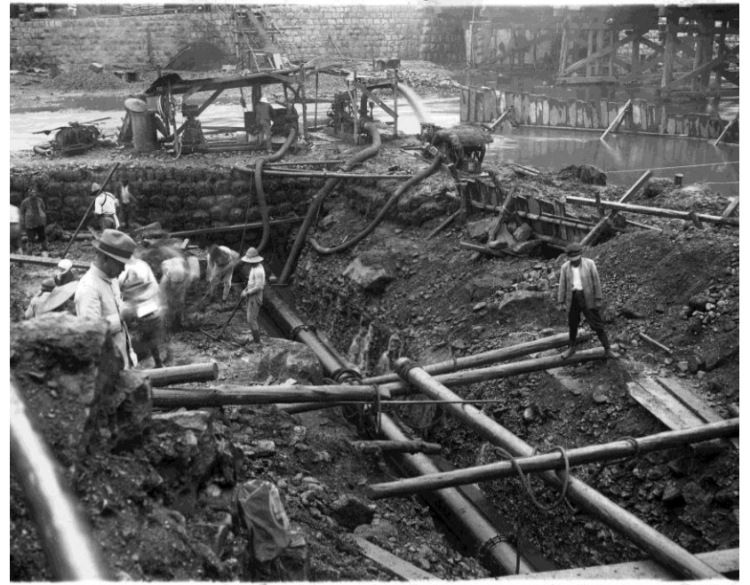
中津川の伏越工事の様子
