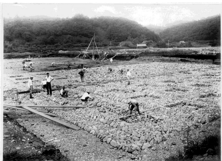
1号ろ過池栗石敷の様子 昭和8(1933)年8月18日撮影
