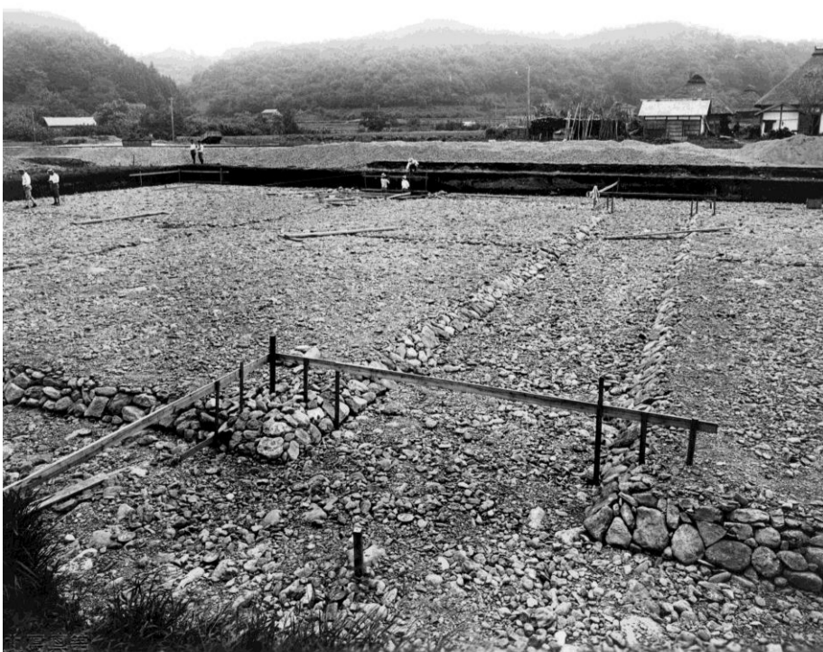
工事中の沈殿池の様子 昭和8(1933)年8月28日撮影
