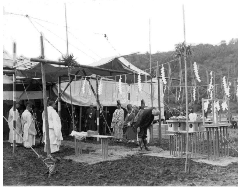
盛岡市上水道起工式 昭和7(1932)年10月17日撮影
