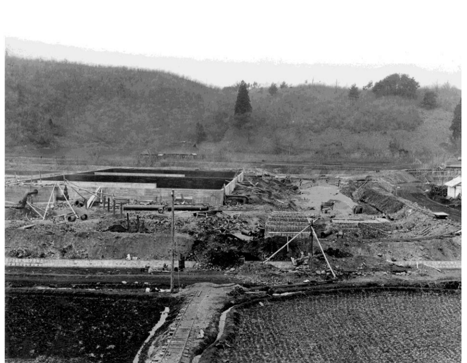
工事中の沈殿池の様子 昭和9(1934)年4月15日撮影
